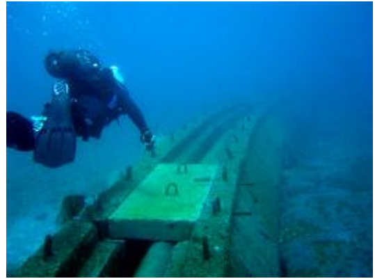
Fig. 17 Colocación de la tubería
