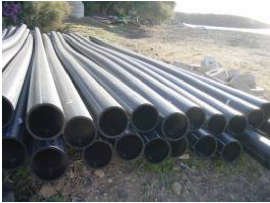
Fig. 16 Montaje de tubos en la costa
