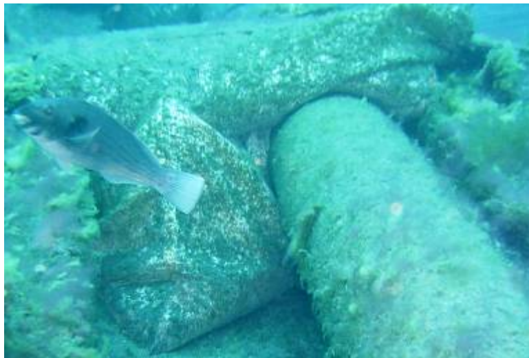
Fig. 2 Sacos de cemento y áridos
