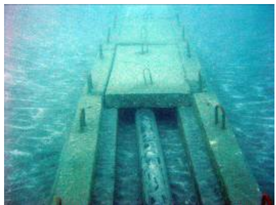
Fig. 19 Cajetín previsto para otra tubería interior
