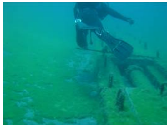
Fig. 11 Levantando tapas durante una inspección
