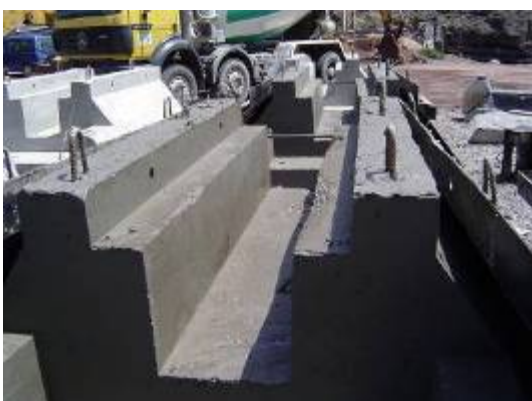
Fig. 14 Hormigonado del Bloque Emite
