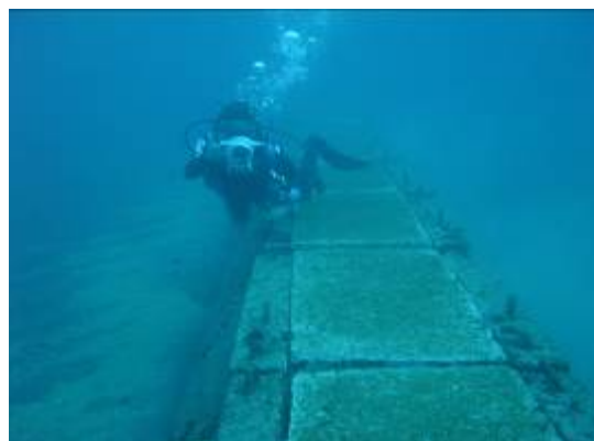
Fig. 13 Con el machihembrado se consigue una perfecta alineación
