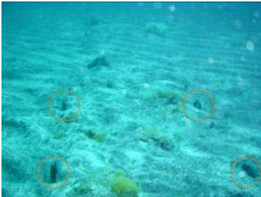
Fig. 10 Bloques Emite enterrados, donde se aprecian las anillas de izado
