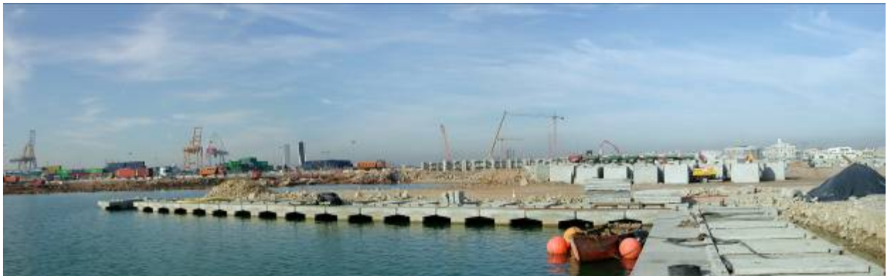
Colocación superpuesta del bloque "BARA"
