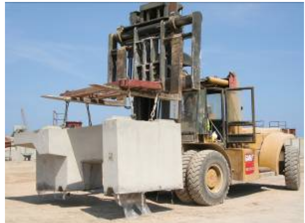
Hormigonado y transporte del bloque "BARA"
