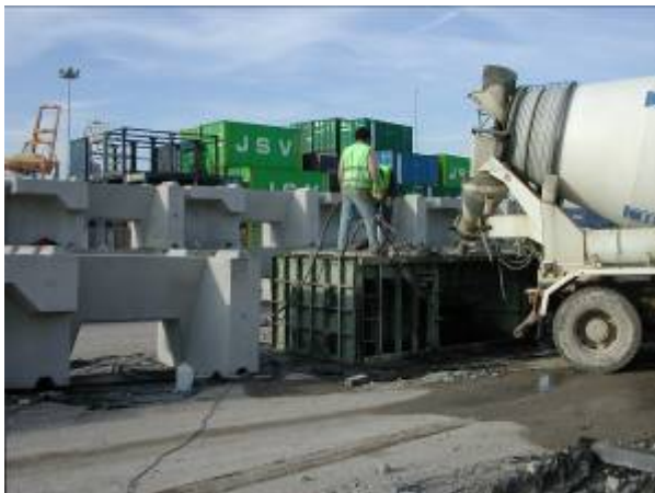
Hormigonado y transporte del bloque "BARA"
