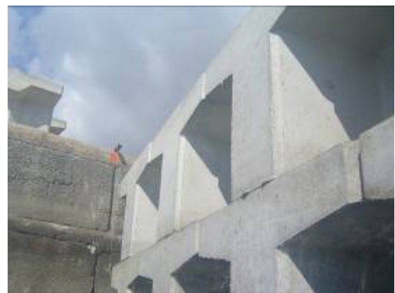
Colocación del bloque "BARA", en el interior de los puertos
